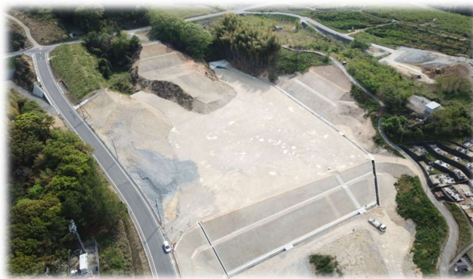
国城寮建替え用地造成工事
