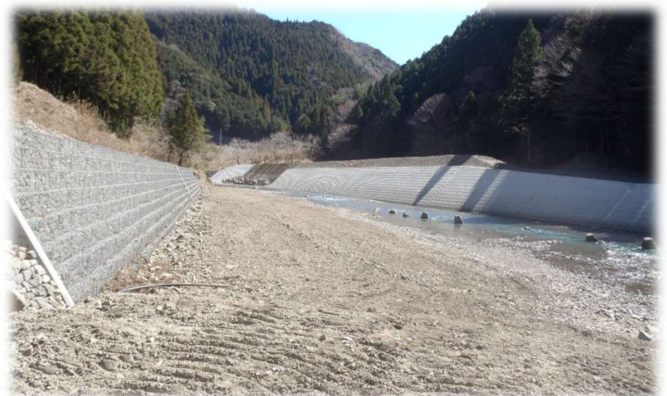
有田川 護岸工事
