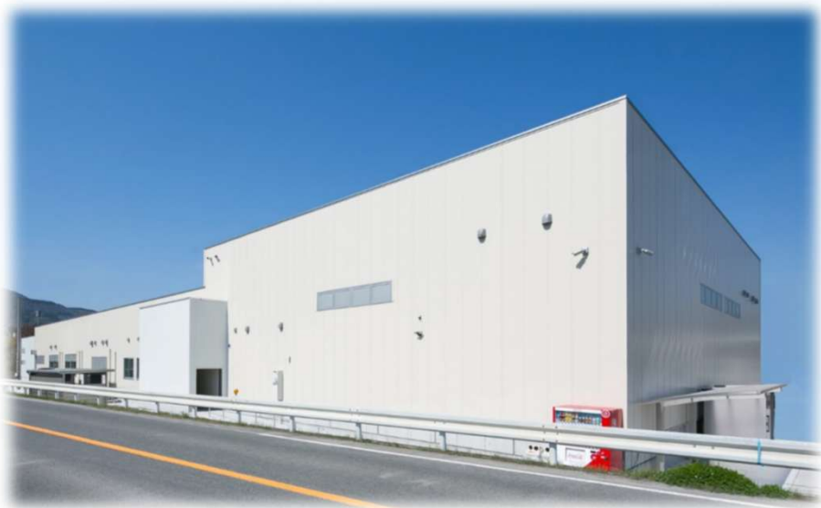
工場棟新築工事
