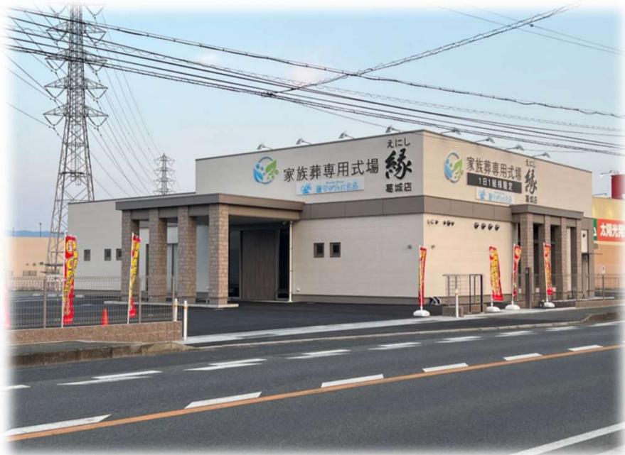
縁 葛城店新築工事
