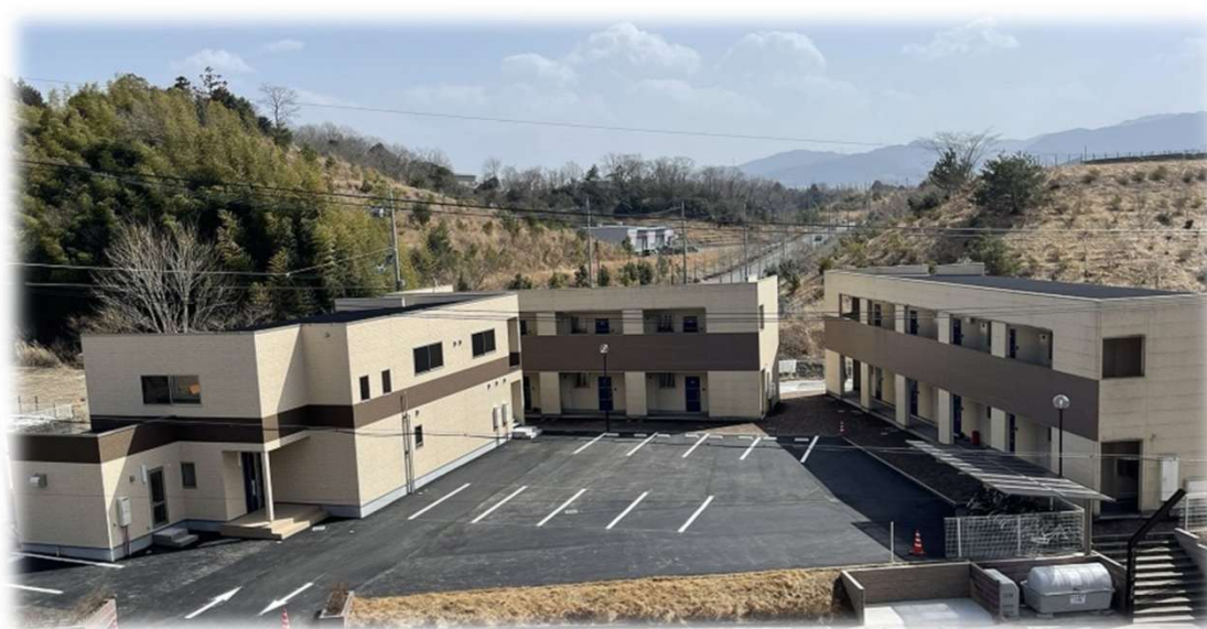
寄宿舍新築工事
